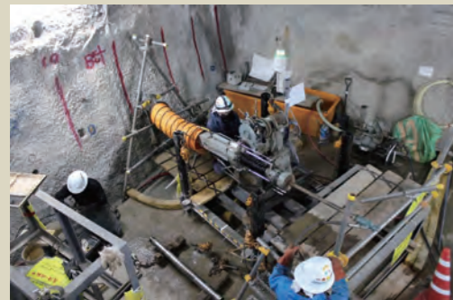
ボーリング作業の様子（物質移行試験）
