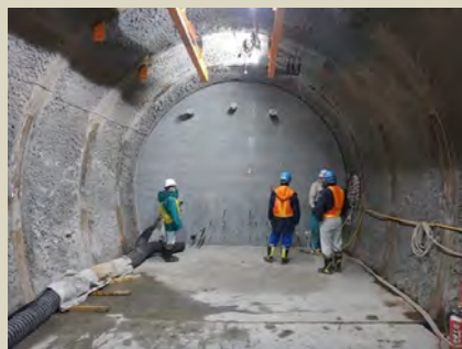
閉鎖技術の一種である コンクリート製の壁（プラグ）の施工
