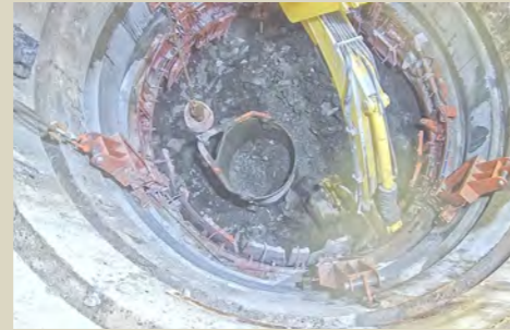
換気立坑での掘削工事の様子
